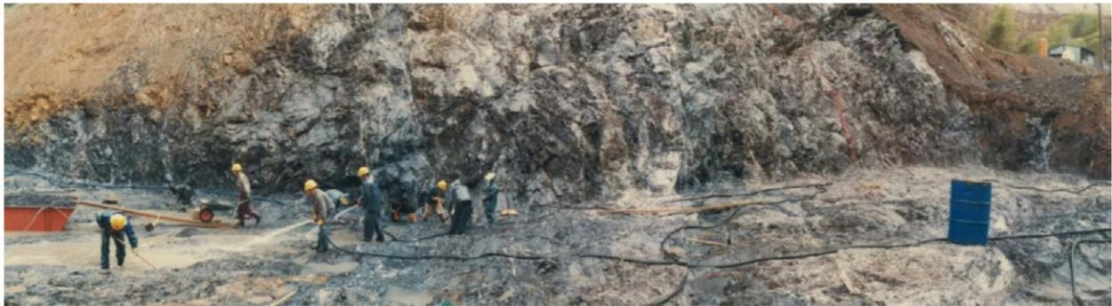
写真 3.2.1 ダム基礎岩盤の洗浄状況
