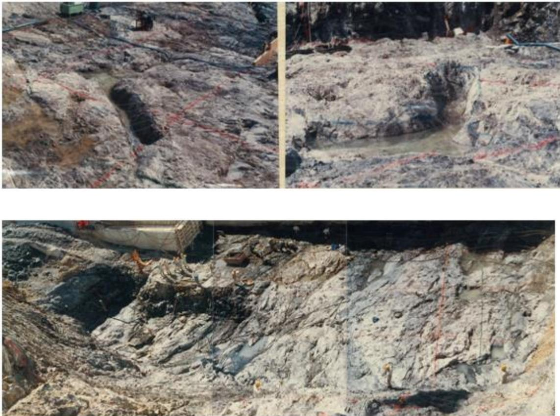
写真 3.1.1 ダム基礎の断層処理（デンタルワーク(上)と置換コンクリート(下)）
